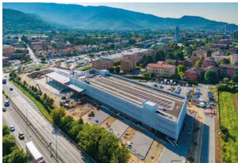
IL NUOVO PARCHEGGIO REALIZZATO AL VILLAGGIO PREALPINO
