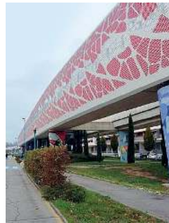
Pannelli. Alcuni sono già stati posati
