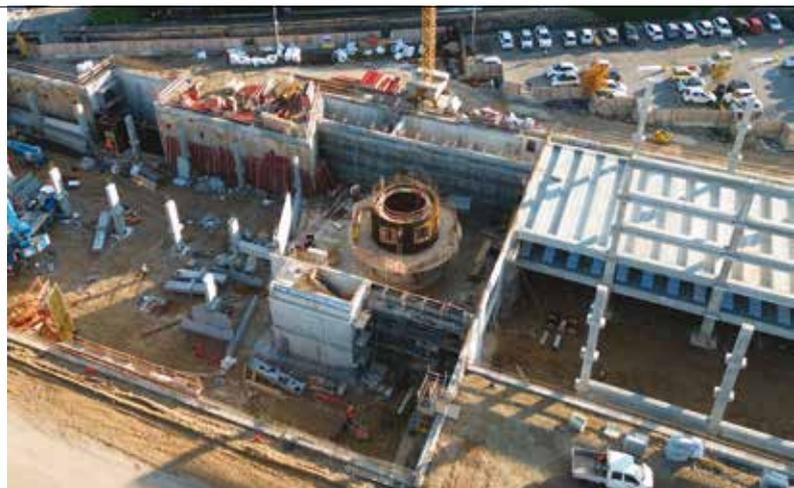
**6.** L'edificazione dei muri perimetrali curvi della rampa di accesso con impiego di casseforme circolari a correnti con snodo (Novembre 2023)
