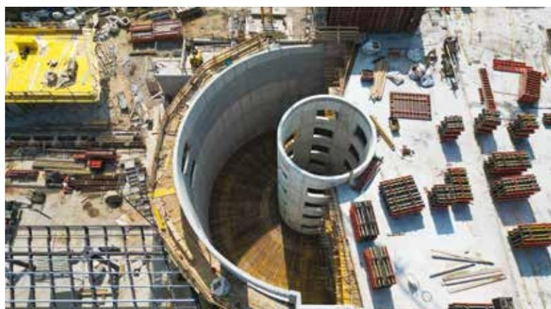
**5A e 5B.** L'edificazione dei muri perimetrali curvi della rampa di accesso con impiego di casseforme circolari a correnti con snodo (Marzo 2023)
