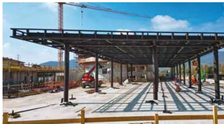
8A e 8B. Le operazioni di posa della carpenteria metallica riguardanti la realizzazione della pensilina insistente sulla zona dedicata ai bus e sulle zone di accesso e uscita nei pressi della rampa circolare (Marzo 2023)
